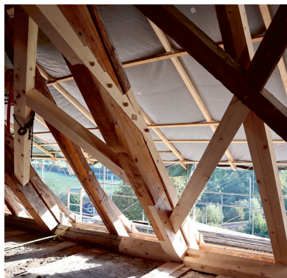
Der Knotenpunkt mit falschem Zapfen und Eichenholzdübeln als Verbindungsmittel.
