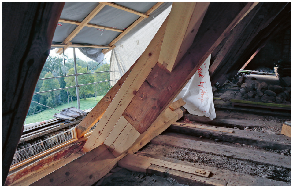
Die Dachbalken waren bis oberhalb der Stuhlschwelle eingemauert, neu gibt es Luft und Vogelschutzgitter zwischen den Sparren. Am Deckenbalken ist von oben die Verbindung mit einer Einhalsung zu sehen.
